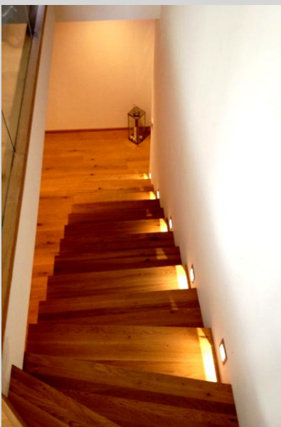
Typische Installation an jeder dritte Stufe
