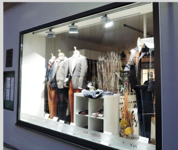
Schaufensterbeleuchtung mit YES-3-Phasen-Strahlern
